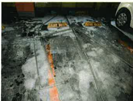
泡流出事故の例
