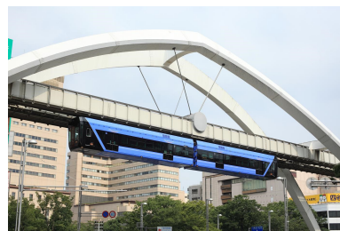
写真一 市街地を走るモノレール
