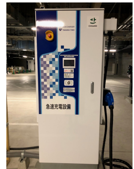
【EV充電器設置状況】
