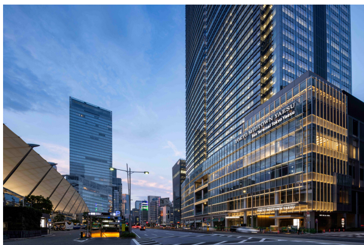
【東京ミッドタウン八重洲 外観】
