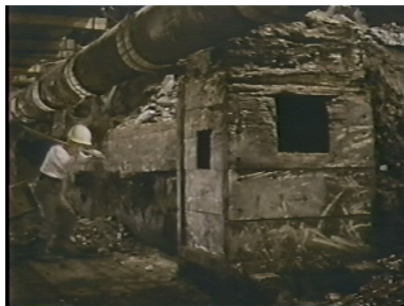
工事施工中の様子 〔「八重洲地下街50年のあゆみ」より〕
