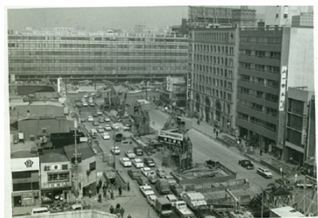
工事施工中の様子 〔「八重洲地下街50年のあゆみ」より〕
