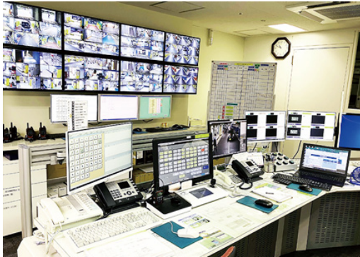
監視操作卓と8面の大型監視カメラモニター
