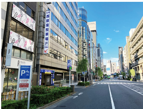
地上車両入口(銀座メディカルビル入口 銀座7丁目)
