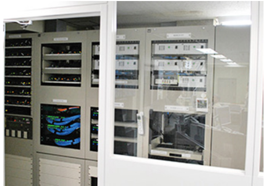
新設マシンルーム：レコーダー等を設置
