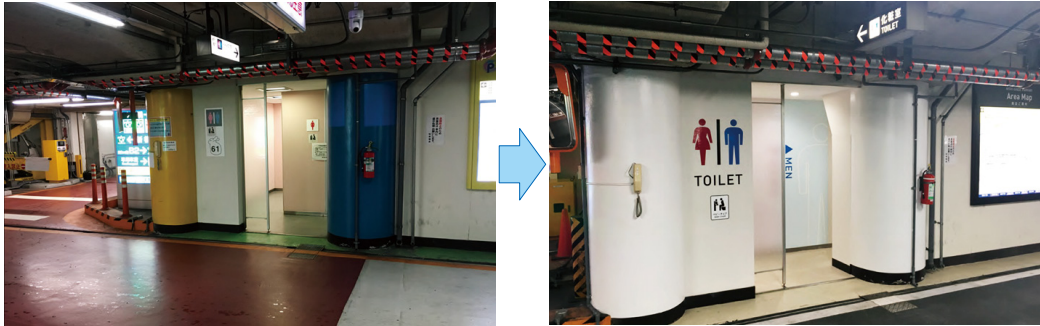
トイレの改修、サイン更新
