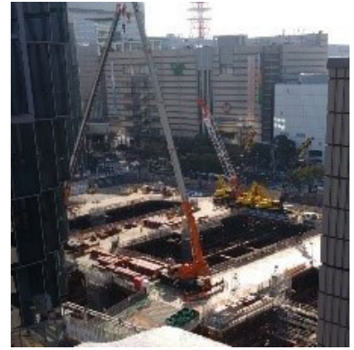
福ビル工事現場
