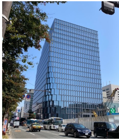
完成ビル第1号(天神ビジネスセンタービル)
