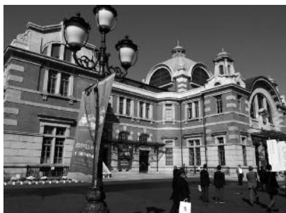
旧ソウル駅舎外観
