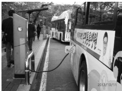
Nソウルタワーにてバス充電中
