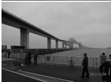
東京ゲートブリッジ
